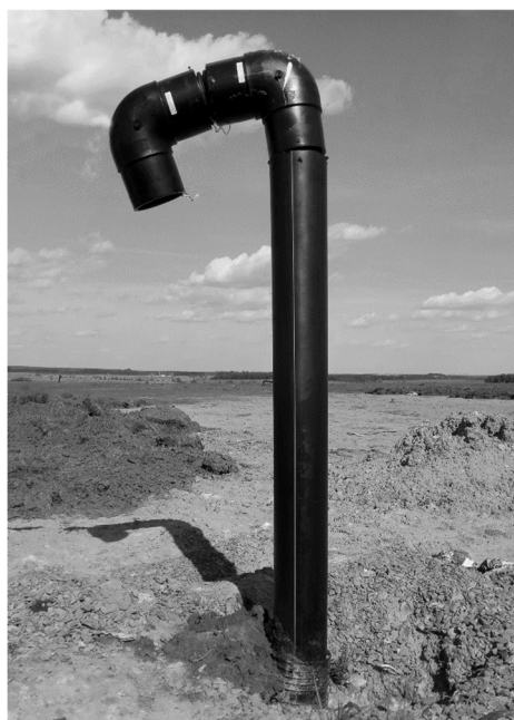
Рис. 7. Общий вид трубы для газоотведения в д. Подиваньково Щекинского района Тульской области
