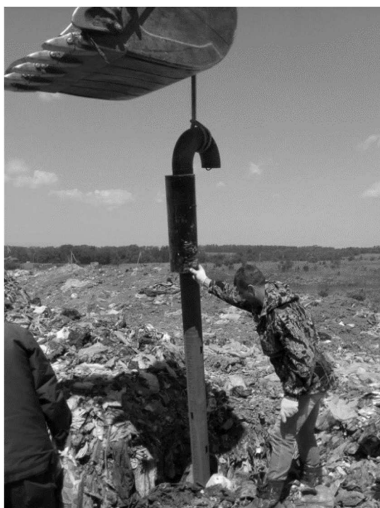
Рис. 3. Установка станции автоматизированного мониторинга действующего полигона ТБО в г. Узловая
