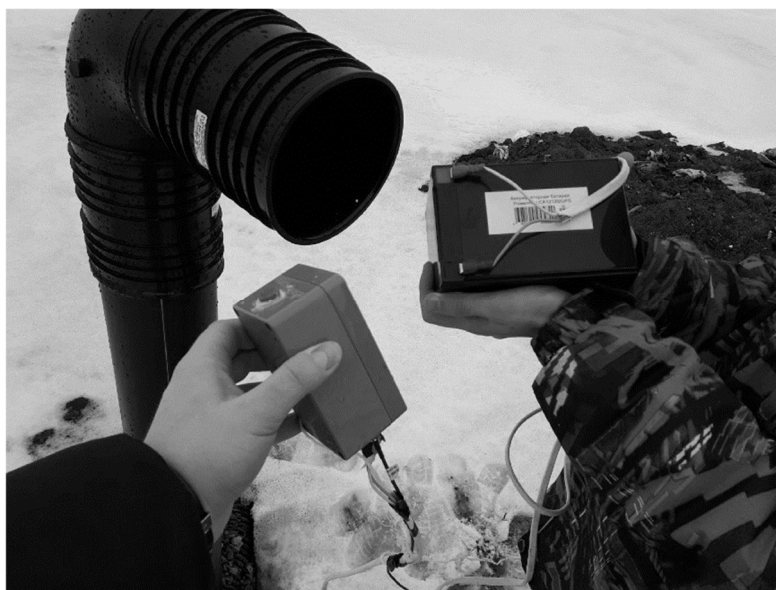
Рис. 6. Установка станции автоматизированного мониторинга состояния рекультивированного полигона ТБО в д. Подиваньково
