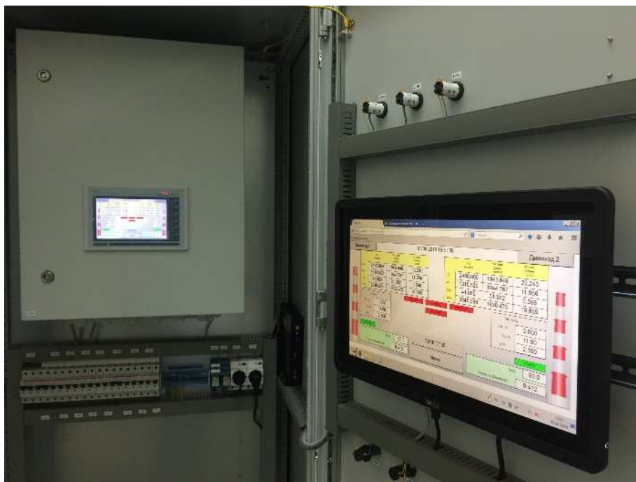
Рис.3. Интерфейс программно-технического комплекса на базе контроллеров, программируемых Siemens SIMATIC S7-300
