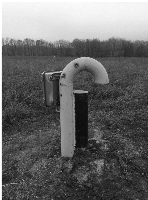
Рис. 1. Станция автоматизированного мониторинга состояния рекультивированного полигона ТБО в д. Судаково Тульской области
