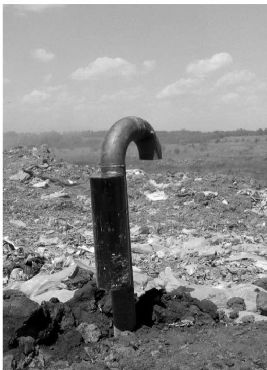
Рис. 4. Станция автоматизированного мониторинга действующего полигона ТБО в г. Узловая
